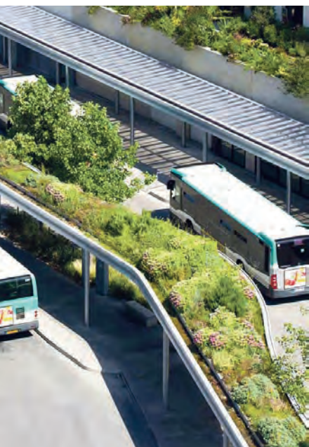
Les toitures végétalisées de Mobipôle : la première gare-jardin du R.E.R.
