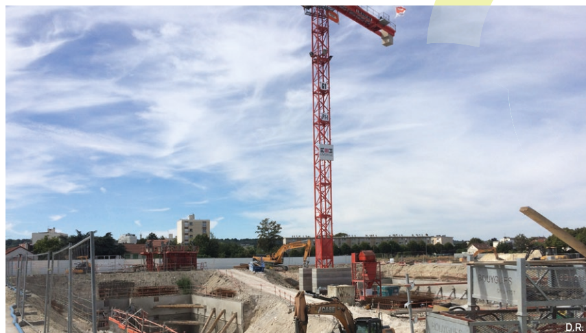
Chantier rue des Bons Raisins
