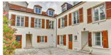
Immeuble - loué et géré par l'agence
