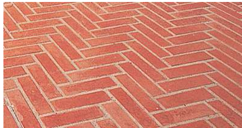
Revêtement de type briques posées sur chants, accès terrasses privées RDC
