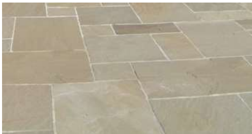
Revêtement de type dalle granit, axe central RDC
