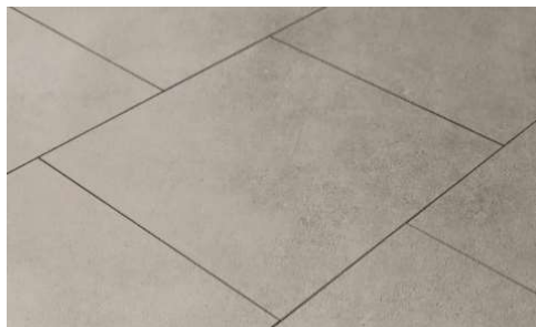
Revêtement de type dallage grès cérame, terrasses privées et bandes stériles RDC
