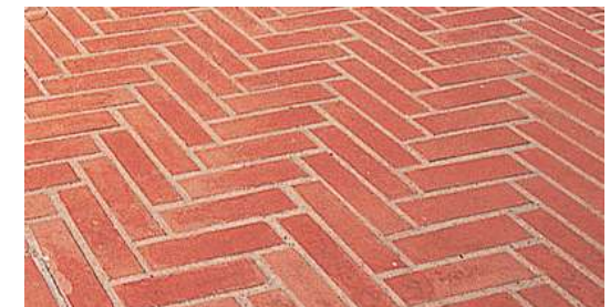
Revêtement de type briques posées sur chants, accès terrasses privatives RDC
