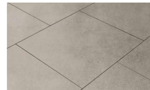
Revêtement de type dallage grès cérame, terrasses privatives et bandes stériles RDC
