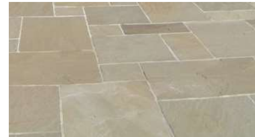
Revêtement de type dalle granit, axe central RDC
