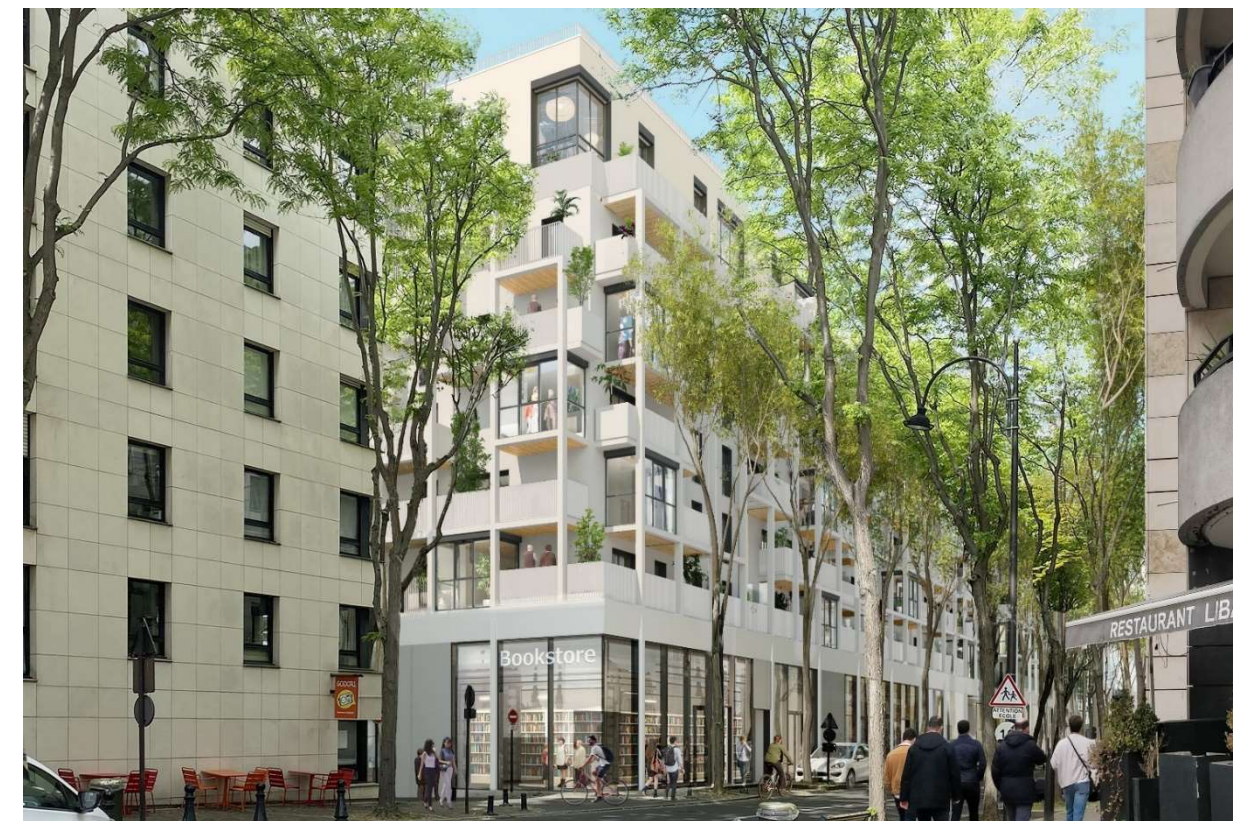
Vue depuis angle rue du Port / rue Blériot
