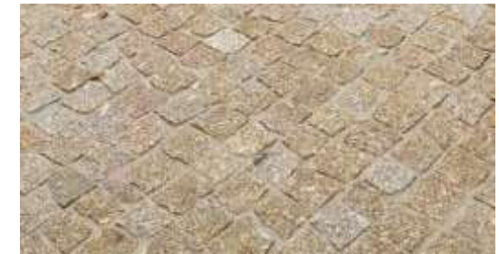
Revêtement de type pavés granit, porche principal RDC
