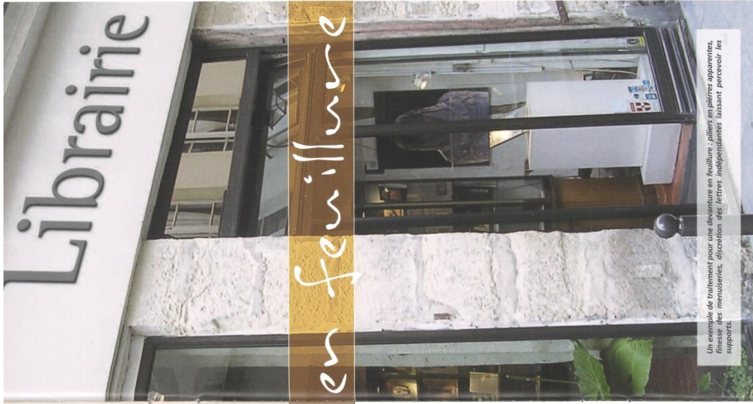
La continuité des parties pleines en maçonnerie assure une bonne descente des charges. L'immeuble donne l'impression de bien reposer sur ses pieds.
