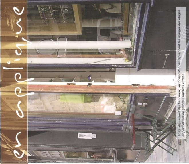
Composition classique pour cette devanture (corniche, bandeau, caisson et soubassement). Les vitrines sont alignées avec les fenêtres de l'étage.
