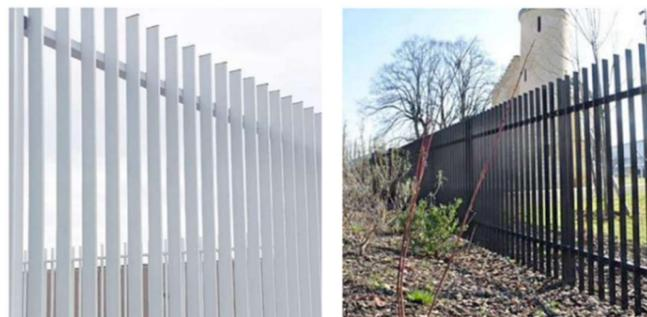
Elles mesurent 2,00 m de hauteur environ et sont posées sur des plots béton enterrés afin de laisser la libre circulation de l'eau en cas d'inondation.
