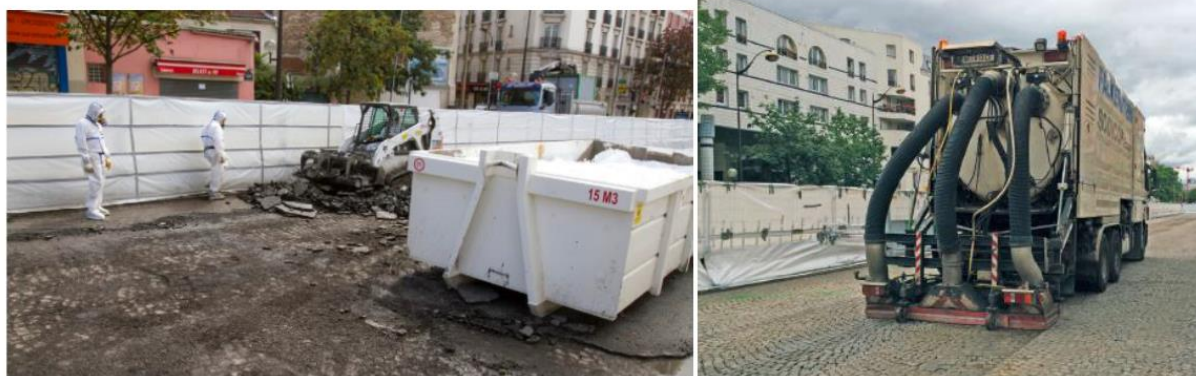
Illustration Opération de désamiantage boulevard Bessières - projet de prolongement du tramway entre les portes de la Chapelle et d'Asnières (source : https://www.tramway.paris.fr/ ) – A droite : illustration d'hydrodécapage des pavés et des joints
