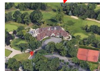
Vue Aérienne du bâtiment situé à l'entrée du Golf
