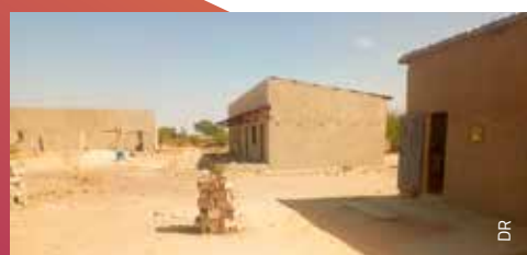
▲ Le chantier de l'école de Forage.
